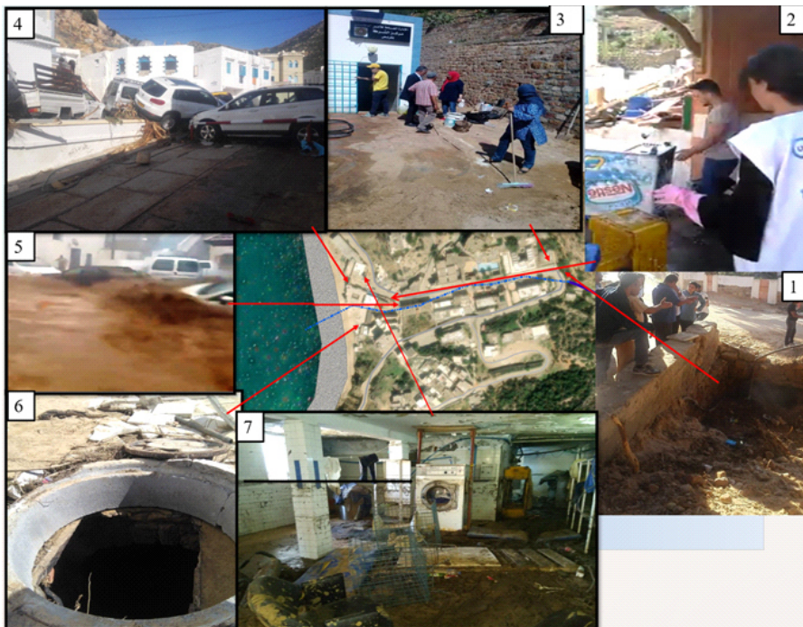
(Fig16). Dégâts observés dans la rue commerciale de Korbous à la suite de l'événement de septembre 2018 Cliché 1 : Débordement du tunnel en 2018 et quelques dégâts observés. Clichés 2 : des constructions en léger totalement détruites. Clichés 3 : Nettoyage du poste de police. Clichés 4 : Clichés 5 : Véhicules emportés par les eaux. Clichés 6 Véhicules endommagés. Clichés 7 : Deuxième effondrement du tunnel de Korbous au niveau de Ain Essbiya.
