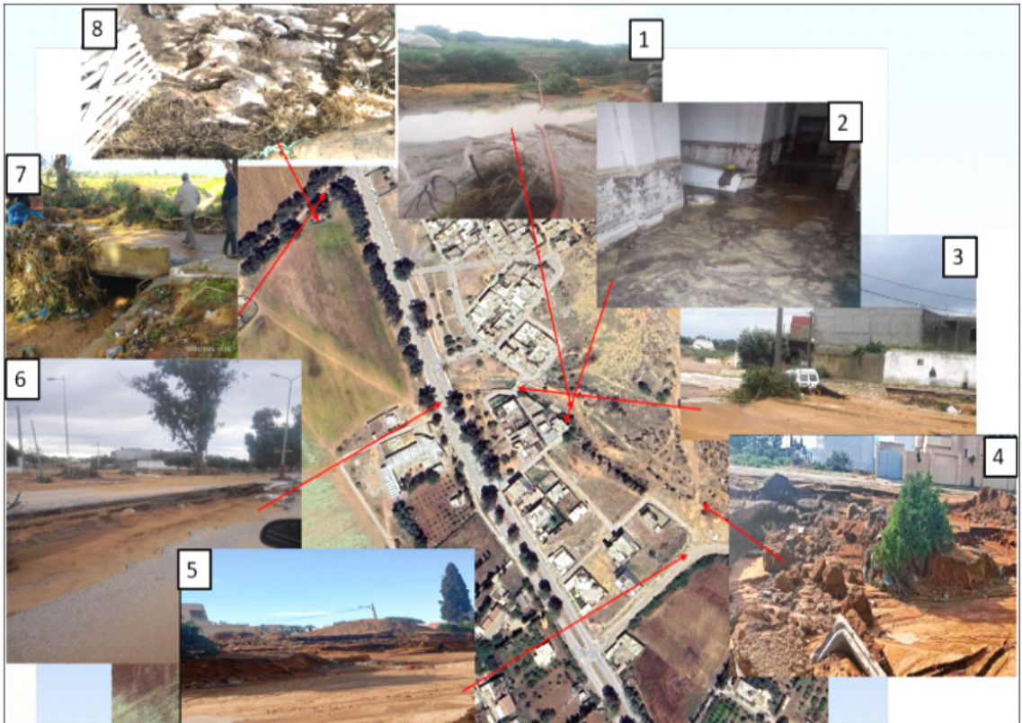
(Fig13). Artificialisation de l'Oued El Mrissa et dégâts induit par le débordement. Source (Photos personnelles)
