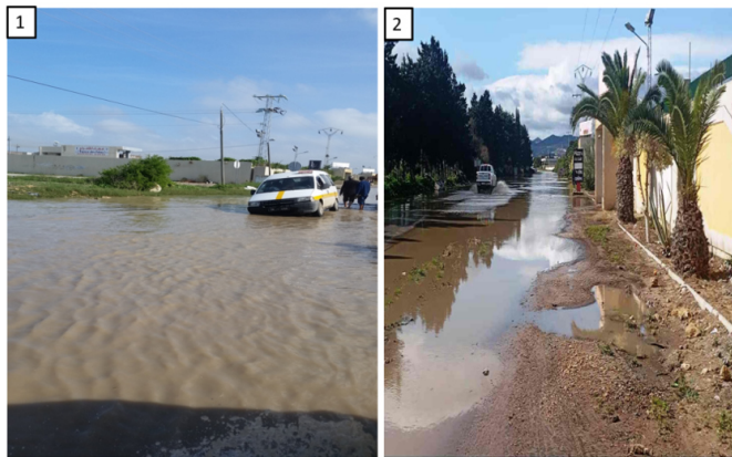
(Fig9). Photo 1 : Coupure de la route MC26 vers Korbous au niveau du parc JinéneLoizir en 22/09/2018
